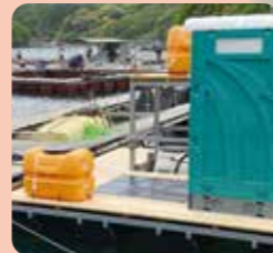
屋外仮設トイレ (バイオ循環ポンプ)
