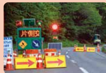
各種工事現場
